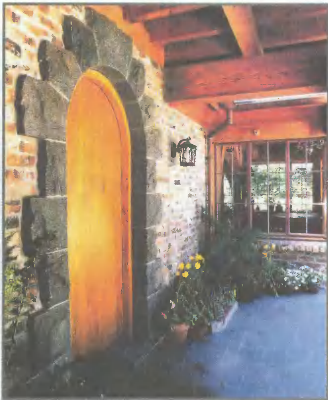
Дверной проем отделан гранитными блоками, обтесанными вручную, а входное крыльцо облицовано плиткой, которая имеет шероховатую поверхность
