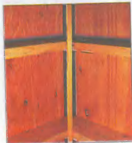
Щель между фанерной обшивкой крыши и коньковой доской, оставленная на всю ее длину, обеспечивает хорошую вентиляцию помещения
