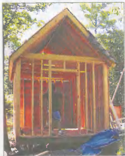
Некоторые решения приходится принимать в ходе строительства. Так, автор определил, какую именно часть стяжек подшить фанерой для устройства «чердака», на котором удобно хранить некоторые бытовые предметы
