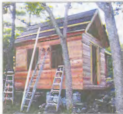
Снаружи стены хижины обшиты кедровой доской. Она долговечна и источает приятный аромат
