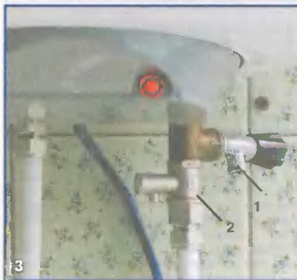
Небольшая доработка облегчает профилактику: 1 — кран для слива воды из бака; 2 — предохранительный и обратный клапан
