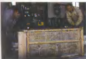
Чтобы преодолеть сцепление с влажным бетоном, внутреннюю опалубку поднимают из ванны с помощью домкратов
