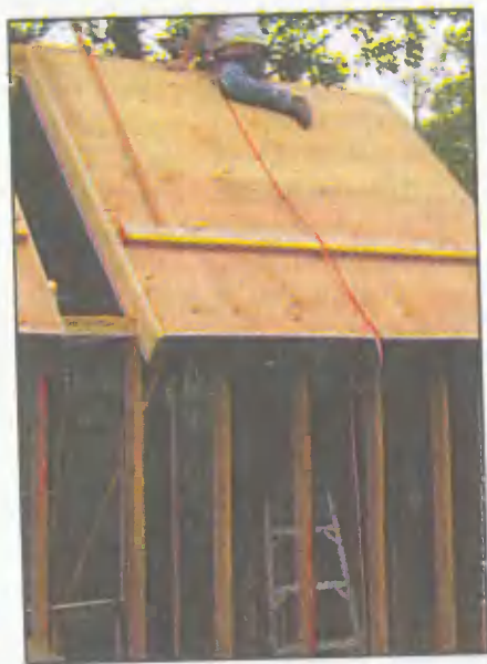
Для выхода на крышу в обшивке между стропилами был оставлен проем. Для большей безопасности проем огражден низким барьером — поручнем. Кроме того, на кровлю опоры уложена доска, поддерживаемая прочными веревками
