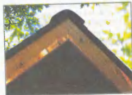
Сплошной вентиляционный канал из полиэстера на крыше накрывает конек
