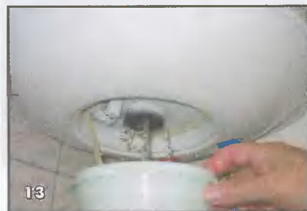
13 Для удаления накипи из рабочего бака необходимо поместить под отверстие, в котором устанавливаются ТЭН и анод, емкость (не менее 10 л) и открыть воду максимальным давлением в системе на несколько секунд. Повторите эту операцию несколько раз, пока вода, вытекающая из бака, не станет чистой, без накипи
