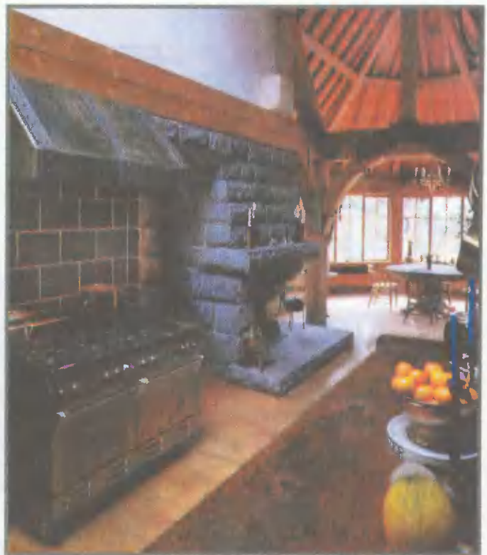
Обеденный стол расположен в нише с деревянным каркасом в северо-восточном конце «амбара». С ним соседствует гранитный камин, который обогревает кухню и столовую. Вытяжной колпак из стальных листов толщиной 6 мм очищает воздух над кухонной плитой
