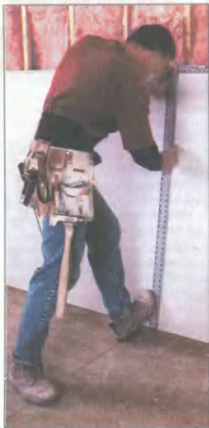
Разметка и резка — это не изматывающий труд. Левыми рукой и ногой фиксируем рейсшину длиной 1,2 м для сухой штукатурки, служащую направляющей
