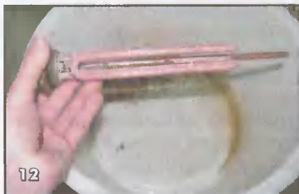
12 Очистите ТЭН и магниевый анод от накипи. Я делаю это в тазике с водой, аккуратно счищая накипь ножом. Если диаметр магниевого анода уменьшился до 12 мм, его надо заменить
