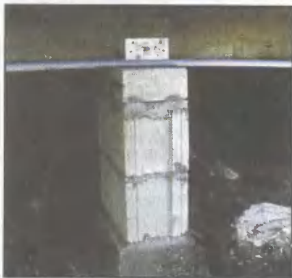
Новые столбы фундамента имеют прочно заделанные крепежные скобы, к которым крепят балки, несущие домик
