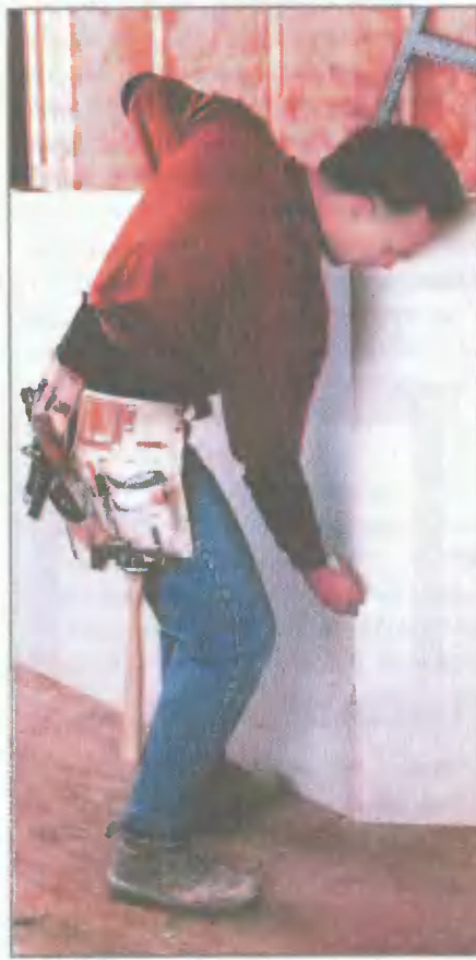
Разрезав поверхность и разломив гипсовый наполнитель, делаем разрез длиной 1,2 м в задней подложке, а затем разламываем лист пополам
