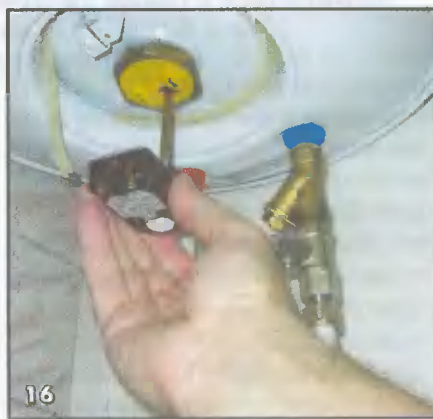
15 Собирайте водонагреватель надо в обратной(!) последовательности. Подключая электрический кабель, первым присоединяете земляной провод. При заполнении бака водой необходимо держать открытым кран-буксу подачи горячей воды на смесителе, пока из крана не потечет вода. Подавать электричество можно только после заполнения рабочего бака водой
