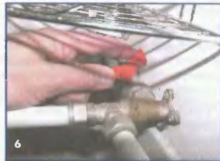
6 Полностью сливаем горячую воду из бойлера и перекрываем поступление воды в рабочий бак
