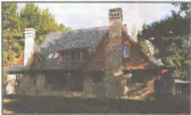
Фронтоны дома обшиты просушенными досками красного дерева сечением 50x300 мм
