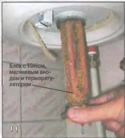
11 Под отверстием необходимо поместить небольшую емкость для слива остатков воды и накипи. Если на ТЭНах накопилось много накипи, которая мешает вынимать их через отверстие, не надо применять силу — делайте это постепенно, покачивая ТЭНы из стороны в сторону и перемещая их сверху вниз по несколько сантиметров
